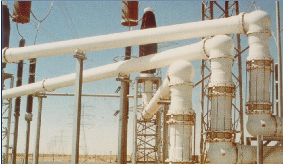
Compensateurs pour installations de distribution d'énergie électrique SF6
