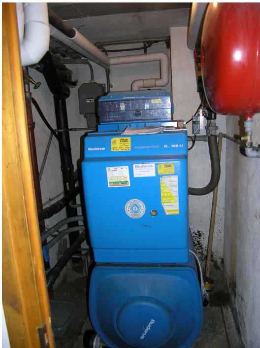
Chaudière à mazout exist.
