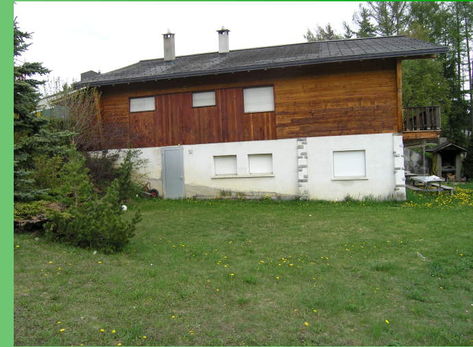
Aces extérieurs local technique
