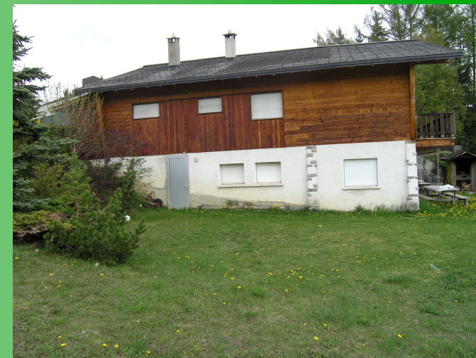
Aces extérieurs local technique
