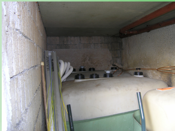
Local citerne - n. chaufferie
